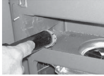
Abb. 2.8 Abgassammelraum aussaugen.
